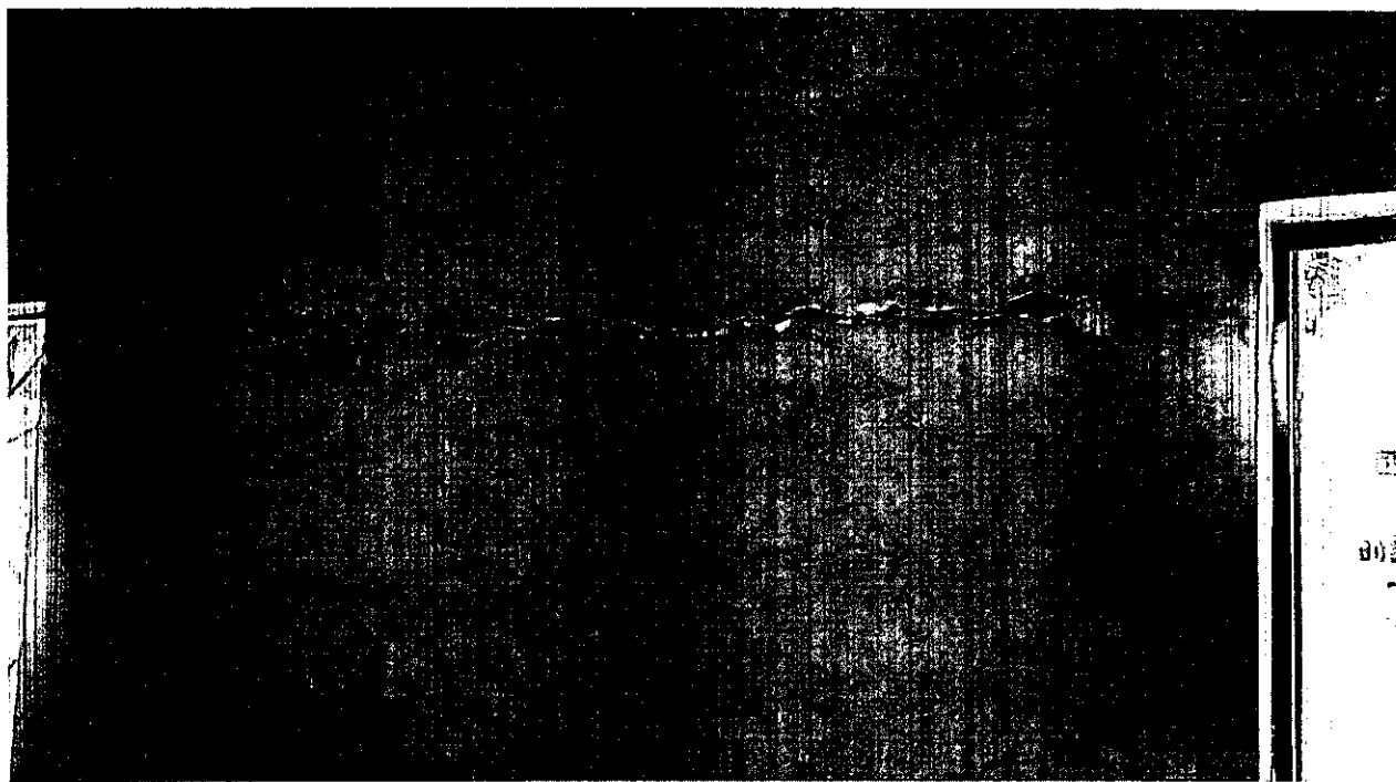
Rachadura na parede de entrada da sala de atendimento (lado de dentro).
